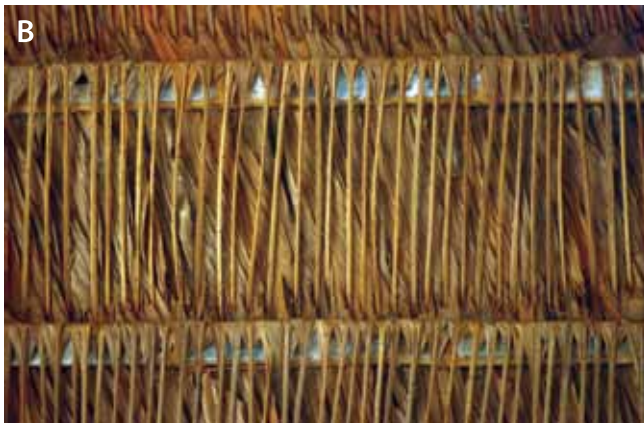
Figura 14-3. (A) Techo con hojas de uksha, comunidad Cofán de Dureno, Sucumbíos. (B) Detalle del tejido de hojas de uksha en los techos de la misma comunidad. Fotos: R. Cámara-Leret.
